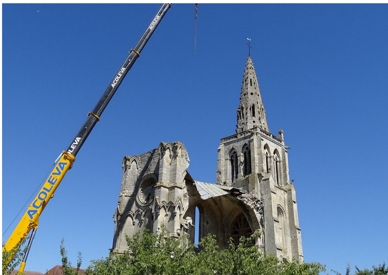
Effondrement de la collégiale Saint-Thomas à Crépy-en-Valois © Pascal Fayolle
